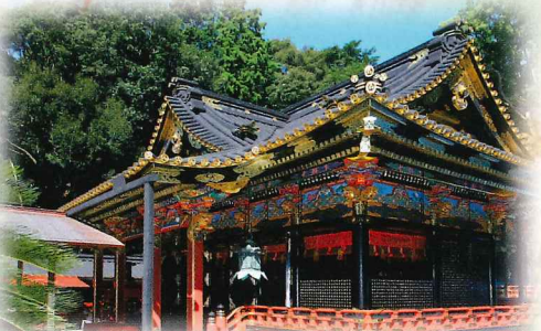
久能山東照宮本社殿
