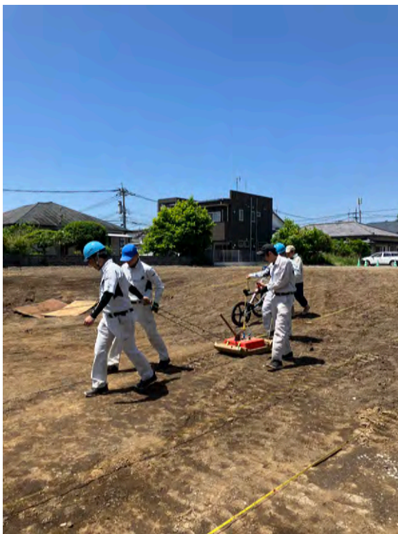
写真 3 地中レーダー探査の実施状況
